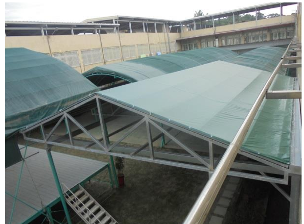
延伸遮雨棚完工
