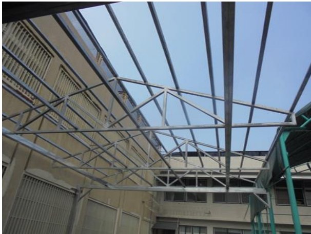
延伸遮雨棚施作
