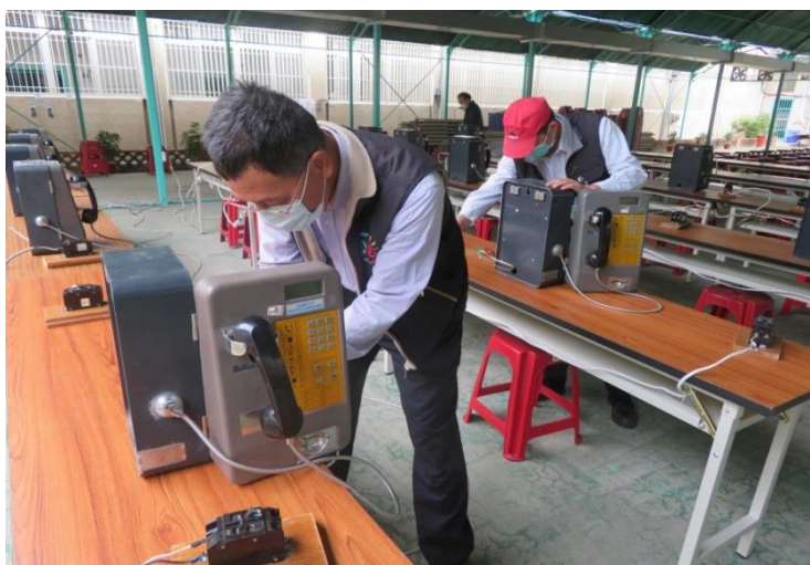
中華電信派遣技師蒞監裝設電話與線路
