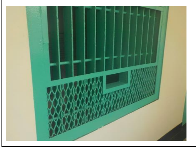
鐵窗上方菱格網拆除與增設送物孔(完工)
