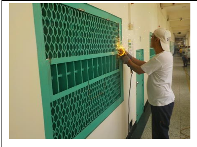
鐵窗上方菱格網拆除與增設送物孔(完工)
