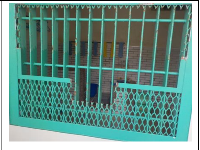
舍房鐵窗上方菱格網拆除作業
