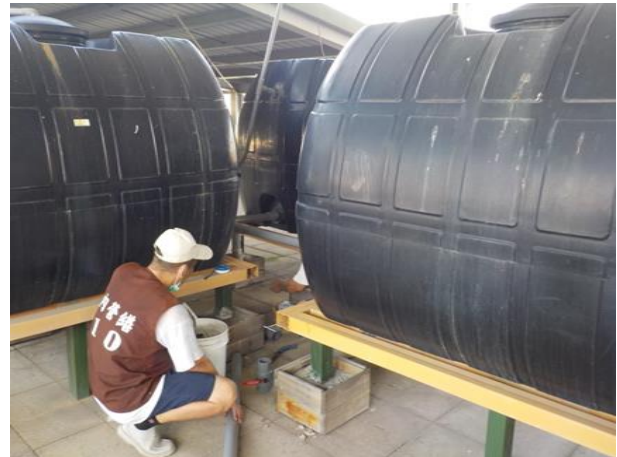
戒護區頂樓集水桶架設完工
