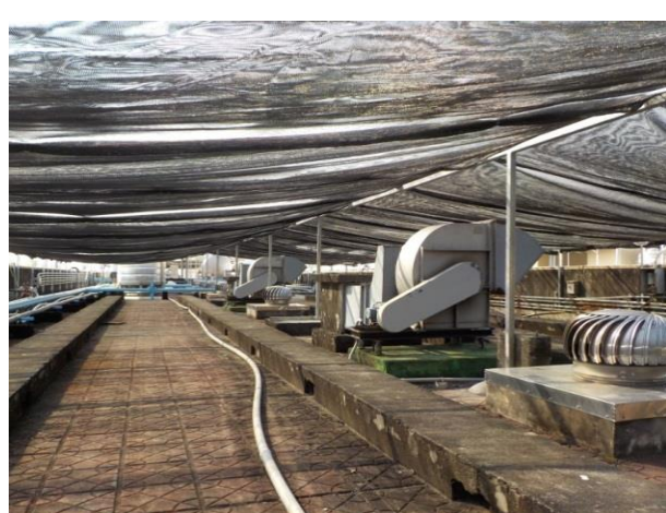
德舍頂樓遮陽網施作完工
