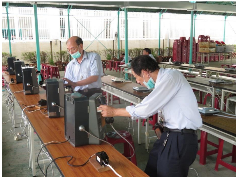
中華電信派遣技師蒞監裝設電話與線路
